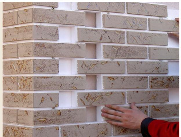
\*Монтаж при низких температурах осуществляется с помощью специального монтажного клея, устойчивого к низким температурам.
